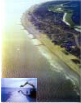
照片 2 美國北卡諾萊納州禿頭島柔性突堤(地工砂管)之應用實例
