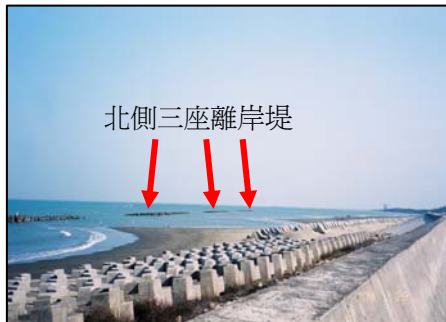
照片 2 嘉義好美寮北側三座離岸堤堤後堆砂效果不佳
