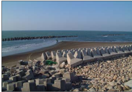
照片 1 嘉義好美寮離岸堤堤後堆砂情形
