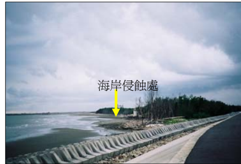
照片 5 嘉義好美寮沿岸流優勢方向下游 (離岸堤北側) 之侵蝕現象
