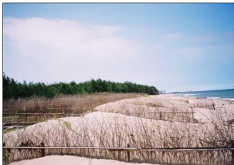
照片 4 嘉義好美寮利用人工砂籬來固砂
